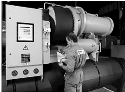
*Figure 4.8 Le contrôle de l'acidité garantit le bon fonctionnement des machines frigorifiques*
