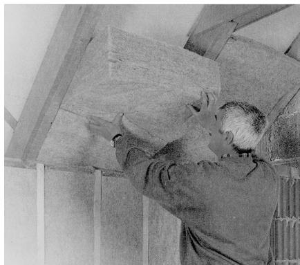
**Figure 1.1** Pose de panneaux de chanvre
