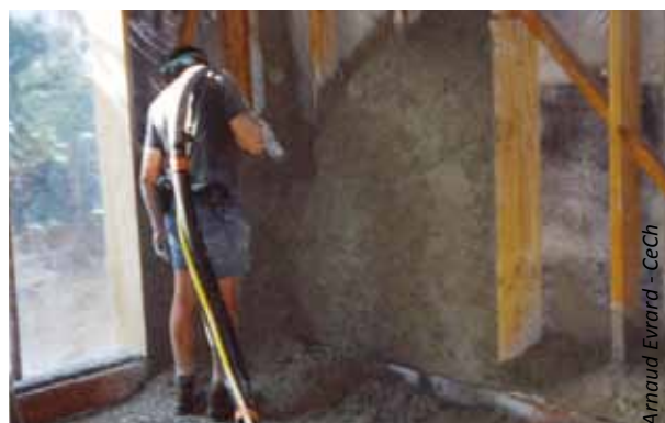
Projection d'un mélange chaux-chanvre entre des structures en bois.
