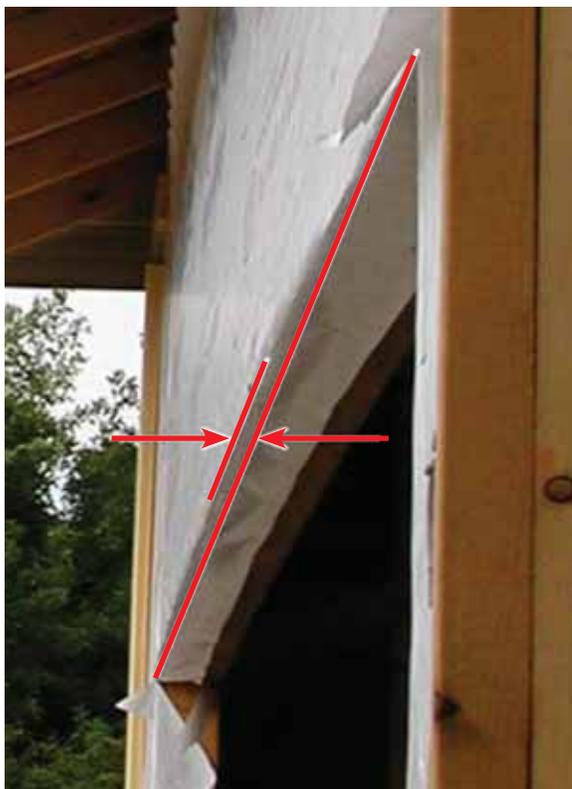
**FIGURE 38** • Flambage d'un linteau en contrebas
