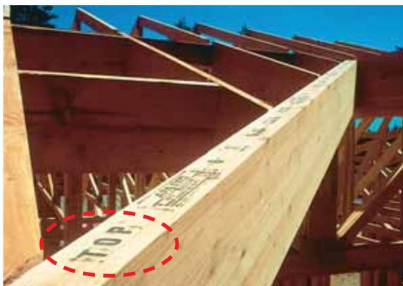
FIGURE 29 • Indication d'un bois lamellé-collé « débalancé » (photo: APA-EWS)
