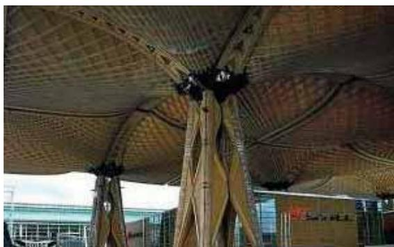
**FIGURE 50** • Résille en bois LVL lors de l'expo Dach à Hanovre (Allemagne) ([www.finnforest.de](http://www.finnforest.de))
