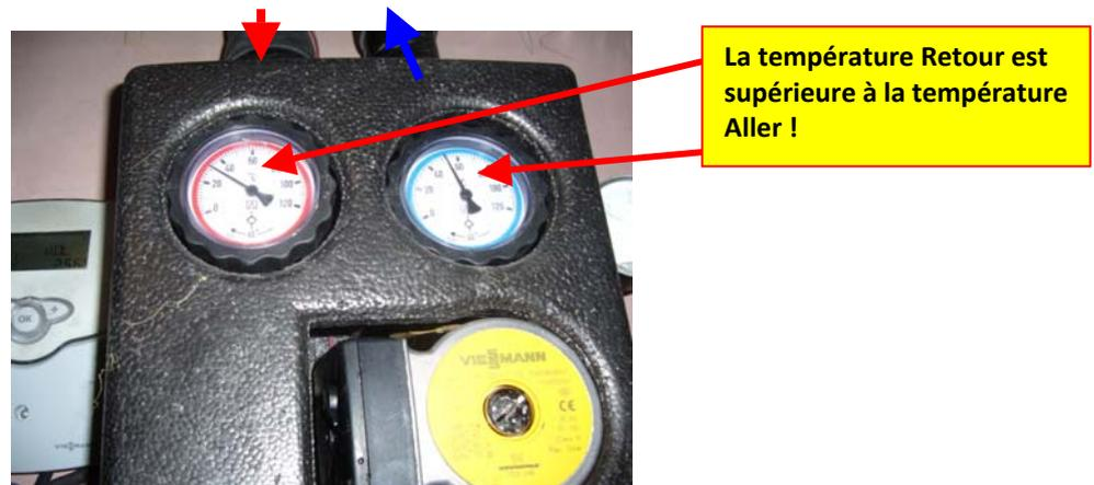
**Figure 1.12 : Température départ/retour échangeur circuit capteurs solaires**
