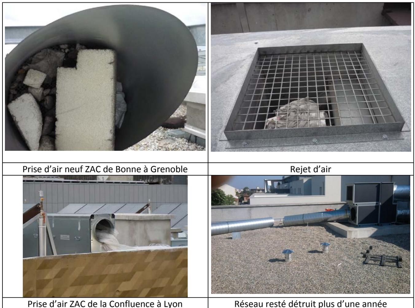
**Figure 2.5 : Etat des prises et rejets d'air observés**
