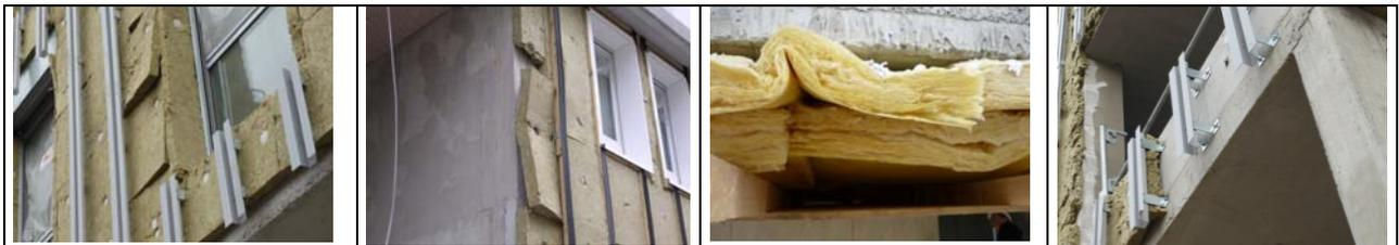
**Figure 1.19 : Isolants posés de façon incorrecte**
