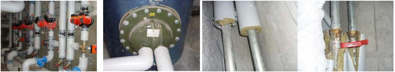
**Figure 1.6 : Absence ou insuffisance d'isolant sur les éléments d'installations**
